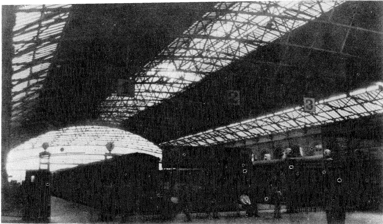
Otro aspecto de la Estación Central: la arquitectura utilitaria dentro de la arquitectura de estilo.
