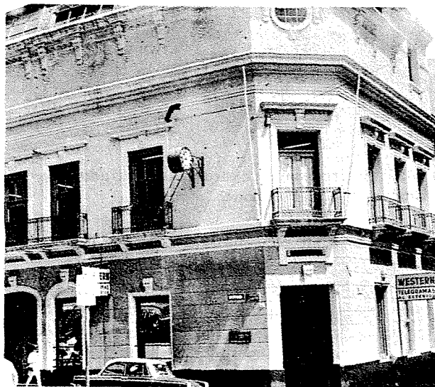
Casa de don Carlos Navia, primera sede del Banco Comercial.
